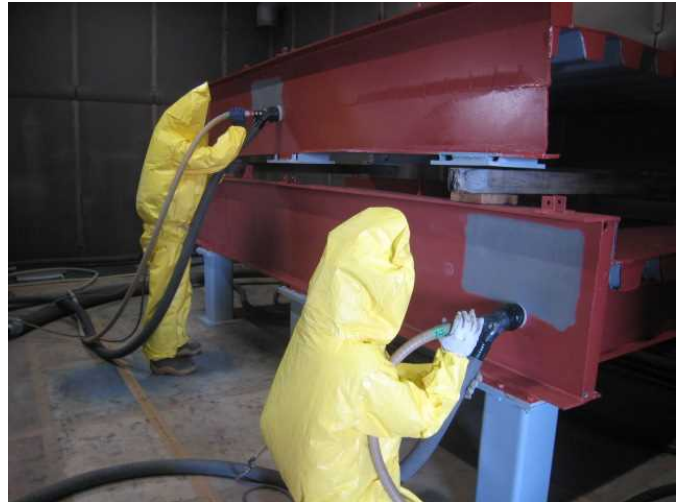
写真-2 ブラスト作業状況
