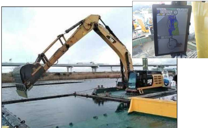
工種名：浚渫工（バックホウ浚渫船）（ICT）
