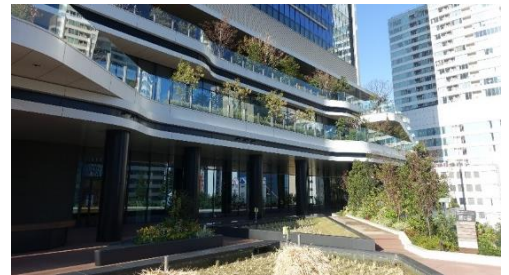
階段状に設けられたオフィスタワーのスキップテラス
