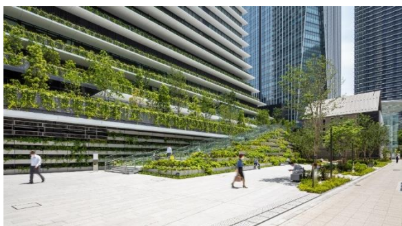
地上から見た低層部の屋上緑化および壁面緑化。手前は港区立西桜公園として整備されている。
