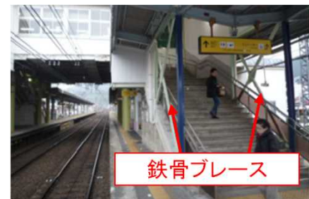
駅等の耐震補強の対策
