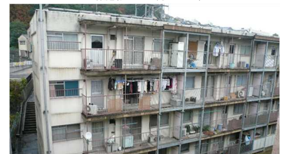
高経年の公営住宅の老朽化対策
