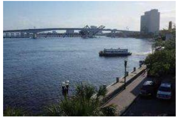
図 2.1.26 図 2.1.25 のエリアを下流側より望む（市の発展に合わせ、Acosta Bridge は 1994 年に開通）
