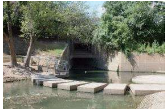
市街地の雨水が暗渠を通じて排水される箇所
