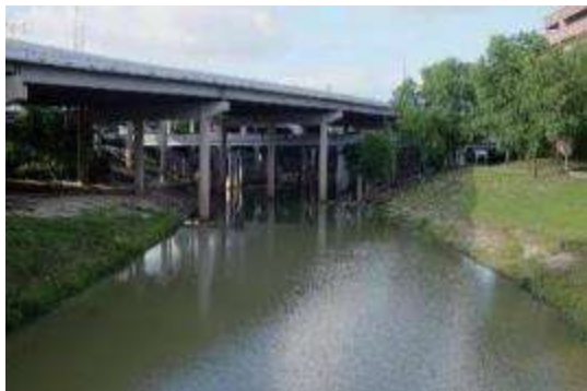
掘り込み河道を渡河する高架道路 —複数の橋の橋脚が河積を阻害—
