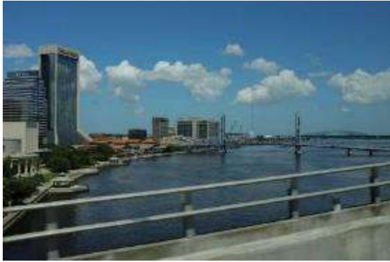
図 2.1.25 舟運の波止場と鉄道旧駅の結節点（現在のMain Street bridgeを望む）
