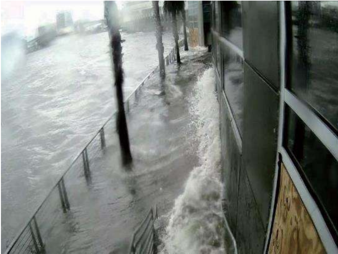
写真 2.4.2 BMC のハリケーン・イルマ襲来時の状況—設置した土のうは流され、ベニヤ板部分から漏水が発生した
