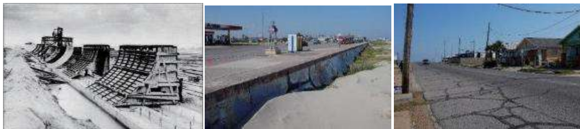
図 2.1.10 ガルベトン地区の海岸堤防（左：築堤時、中央：海側、右：陸側）
