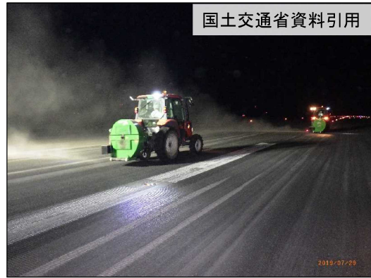
【除灰清掃作業中の様子】
