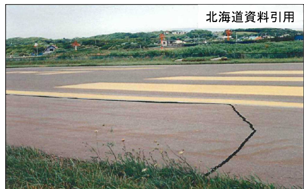
【滑走路に生じた亀裂の状況】
