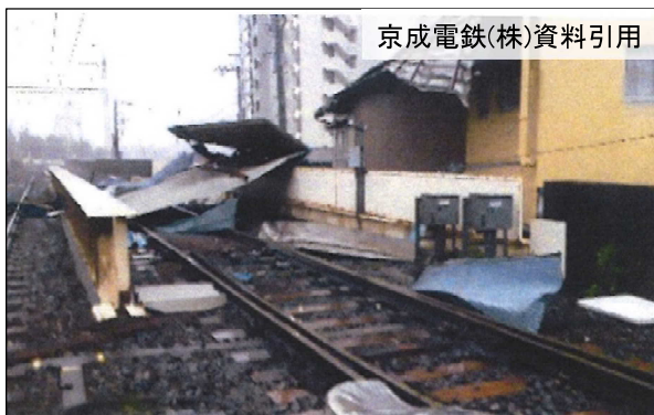
【成田駅構内(家屋倒壊・軌道内支障)】
