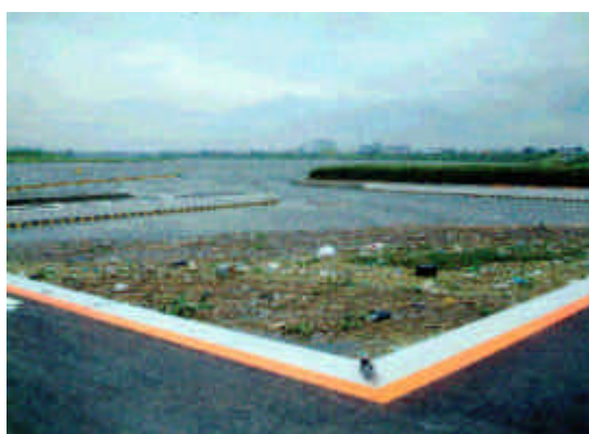
完成後の出水では、さっそく効果を発揮した
