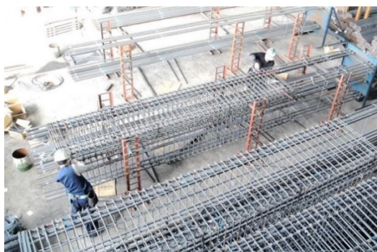
梁鉄筋工場地組
