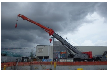
ラフタークレーンによる施工
