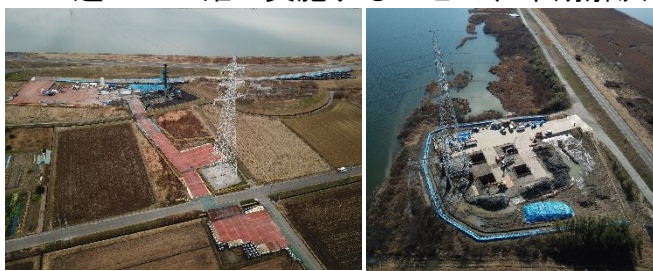
ドローン画像による現場状況確認
