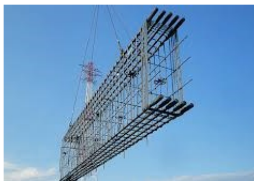
梁鉄筋地組取付
