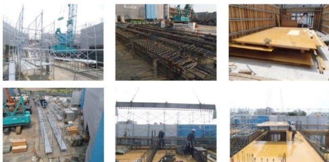
地組(足場・型枠・鉄筋)のイメージ
