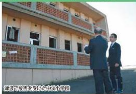
津波で被害を受けた中元小学校の校内
