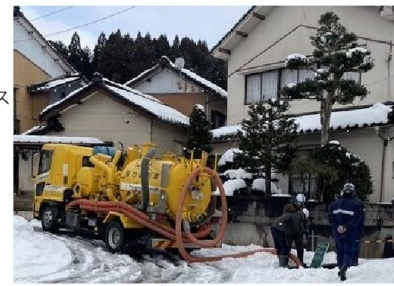
能登町 バキューム車により下水処理場へ運搬
