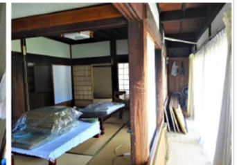
空き家縁側改修前
