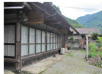
空き家外観改修前
