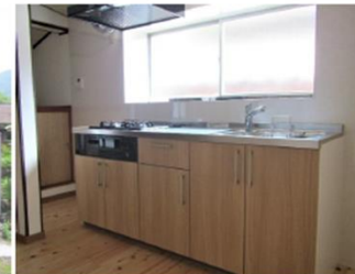
空き家台所改修後
