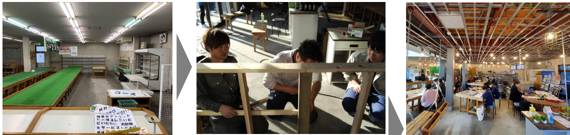
<町民と関係人口らで施設の改修を行った>
