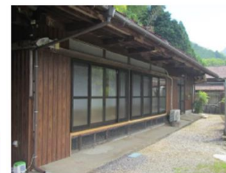
空き家外観改修後
