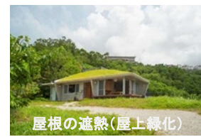
屋根の遮熱(屋上緑化)
