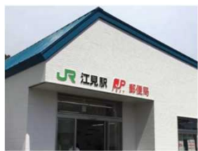
駅舎の 新改築・移設
