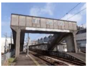
既存施設の 撤去
