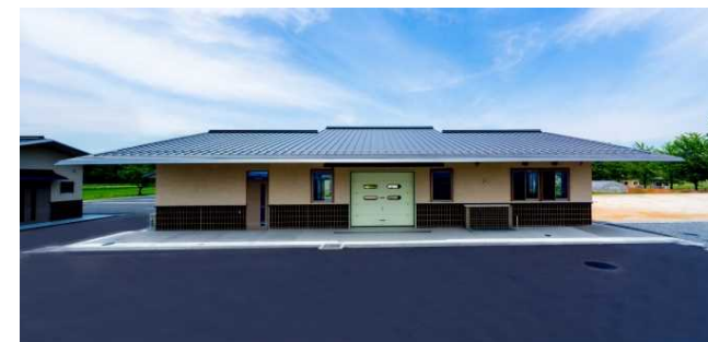
農林水産研修所つくば館水戸ほ場 管理棟
