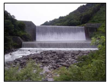
小水力導入前の砂防堰堤
