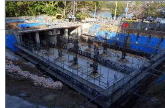
父島第二原水貯水池 地中内躯体工事
