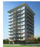
CLTを用いた10階建て共同住宅
