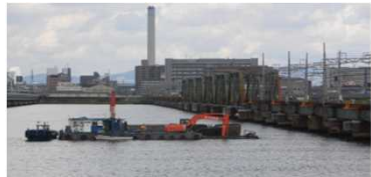
橋梁架替工事における船舶の利用
