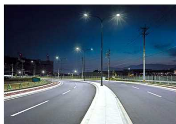
LED照明による省エネ効果 消費電力約6割削減(高圧ナトリウム灯比) 出典：令和3年度 道路分科会 基本政策部会資料
