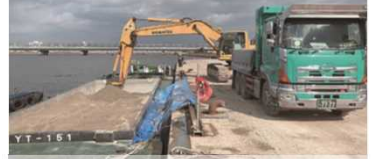
淀川左岸線工事における船舶の利用
