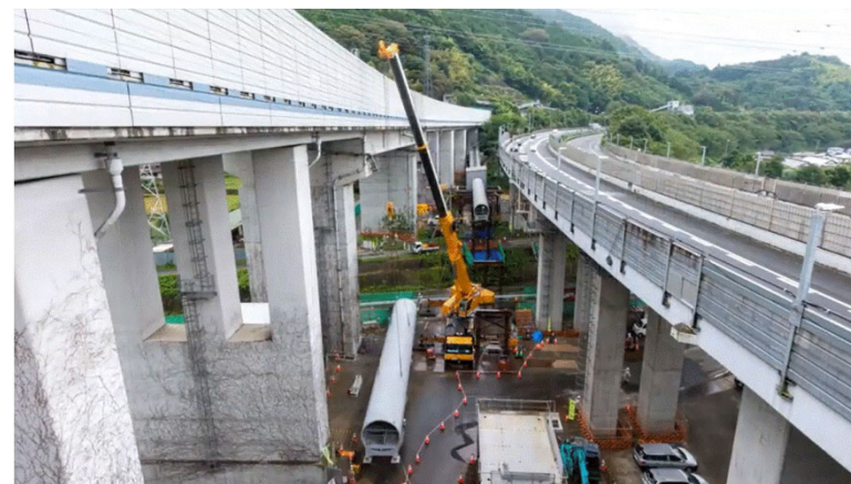
実際の施工風景
