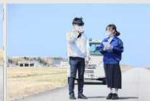
路面を叩いて行うキズ点検。履歴は写真と文書で記録していたが、HoloLens 2 を装着すれば、点検履歴が視界に表示される
