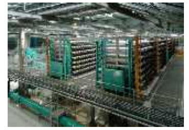
施設内部(膜の配置状況)
