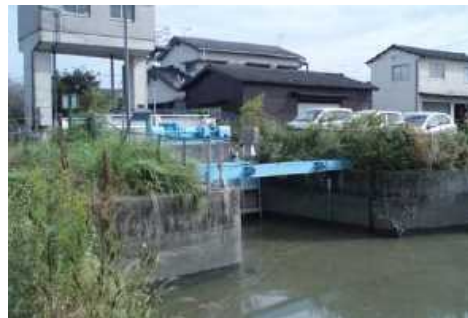
田川城島2号排水樋門
