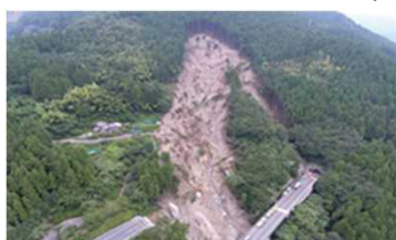
図2 寸断された高速道路
