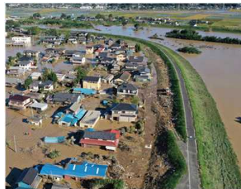
堤防が決壊した都幾川(埼玉県東松山市) 東日本台風の被災状況
