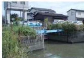
田川城島2号排水樋門
