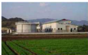
城原金立揚水機場
