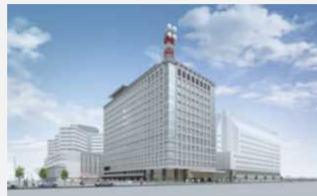
【大阪第6地方合同庁舎 (仮称)】
