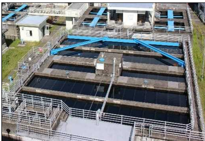
【高速凝集沈殿池耐震化工事】
