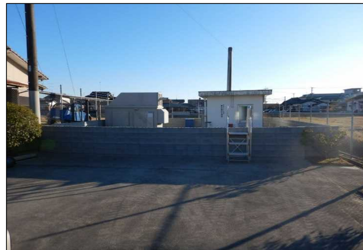
【水源地の施設周辺】
