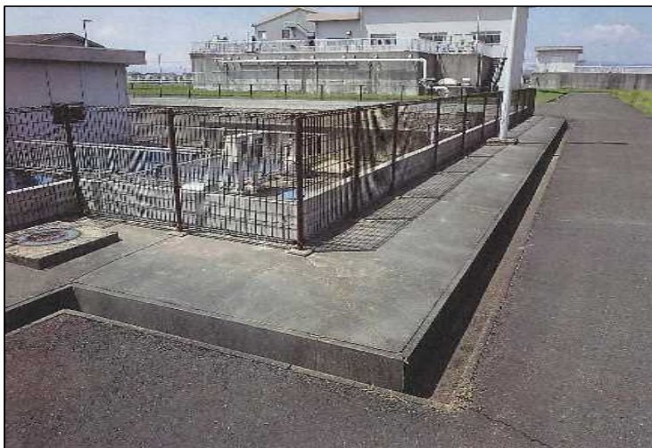
【排水処理施設周辺】
