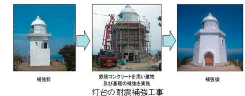
灯台の耐震補強工事
