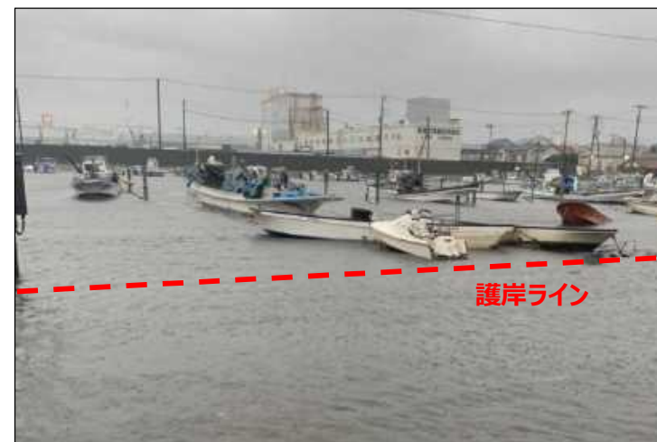
護岸背後への浸水状況
