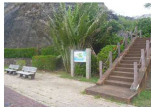
出入口の老朽化
