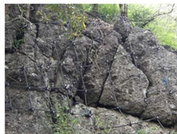
落石防護網の設置や落石の除去
