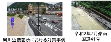
河川近接箇所における対策事例
