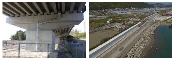
緊急輸送道路上の橋梁の耐震化
