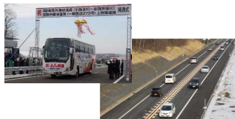
釧路外環状道路(釧路東IC~釧路別保IC) 釧路中標津道路(一般国道272号)上別保道路開通 (平成31年3月)
