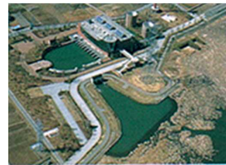
北千葉導水施設(国土交通省) H11事業完了
