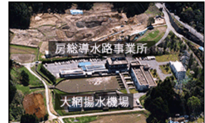
大網揚水機場
