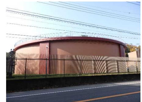
中里中継ポンプ場(調整池)
