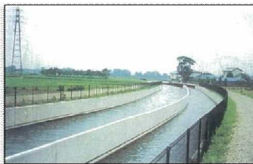
利根中央土地改良事業造成施設(農林水産省) H15事業完了
