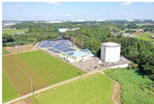
北総中央土地改良事業造成施設(農林水産省) R2事業完了予定
