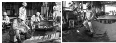
ぎょう鉄(鉄板曲げ加工)
