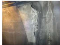
▲トンネル目地部
