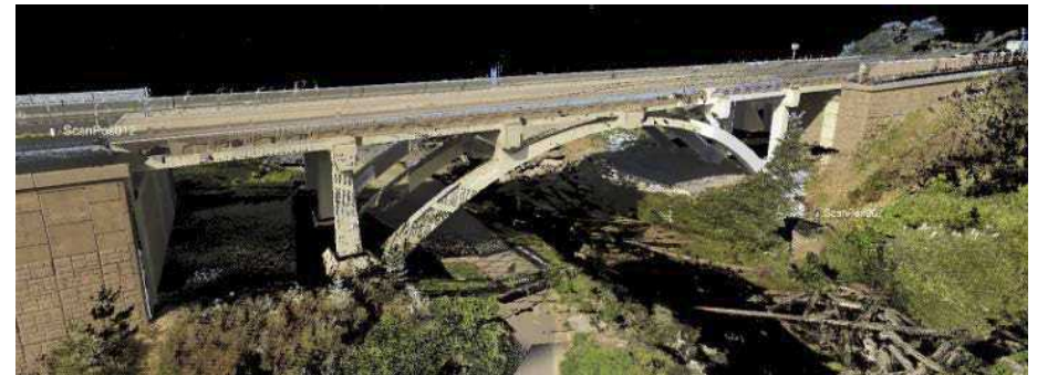
図-1 オレゴン州101号線のスプリングクリーク橋の点群データ
