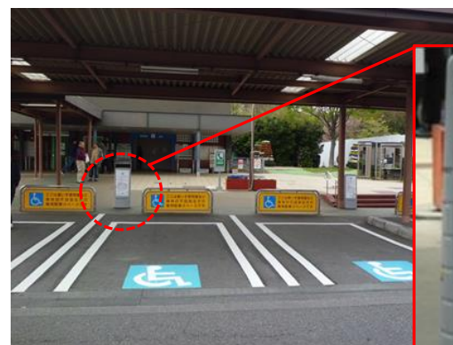
屋根付き優先駐車スペース （守谷SA（下り線））
