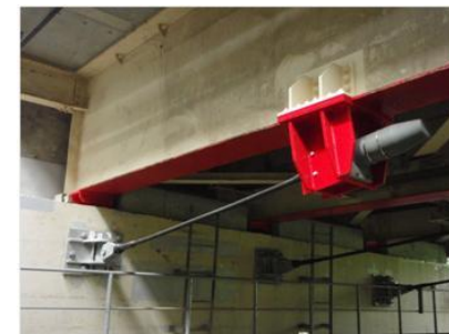
＜対策例2：落橋防止構造＞
