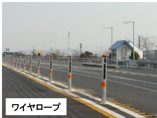
〈暫定2車線(土工区間)に設置しているワイヤロープの状況〉 磐越自動車道
