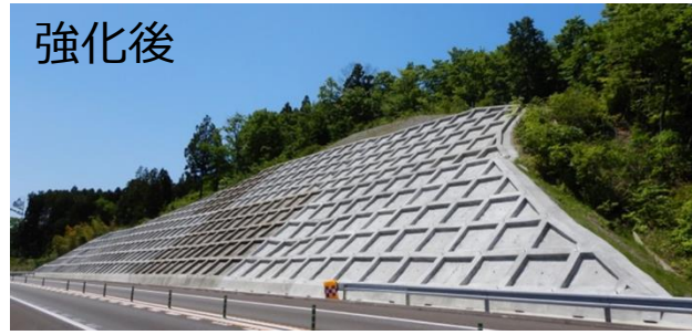
〈常磐道 のり面補強の事例〉
