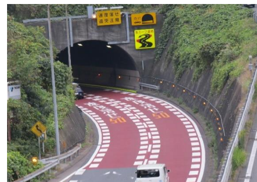
〈薄層舗装・導流レーンマーク ・注意喚起標識〉
