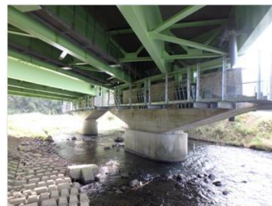
＜対策例1：橋脚全体の補強＞
