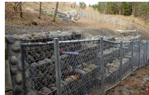
〈盛土のり面補強の事例〉
