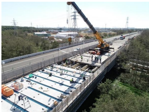
道央自動車道 勇払川橋の床版更新工事の状況
