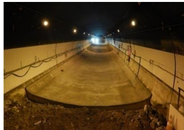
インバート施工例
