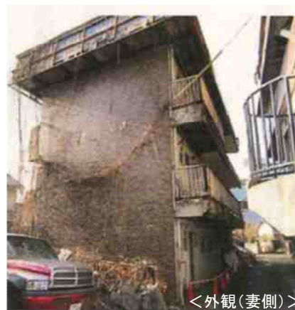
外壁、手すりが崩落した事例
