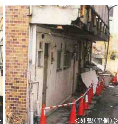
外壁、手すりが崩落した事例
