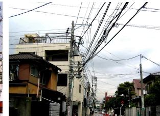
電線類により 景観が損なわれているまちなみ
