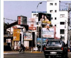
看板等の無秩序な乱立により 雑然とした景観
