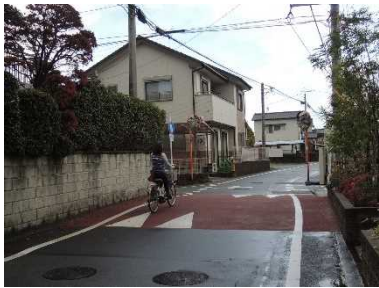
車両速度抑制対策(ハンプ)を実施(久留米市)
