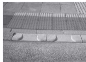
車いす、ベビーカーが 通りやすいように段差 を一部解消した縁石
