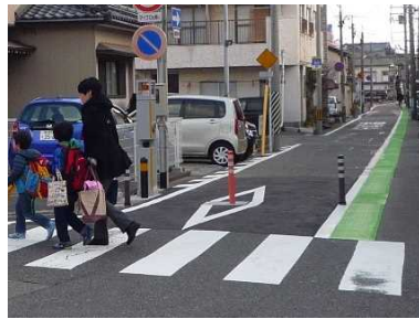
車両の時間通行規制とあわせてライジングボラードを設置(新潟市)
