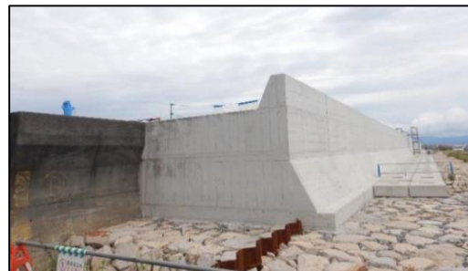
粘り強い構造の堤防整備 (高知港海岸)
