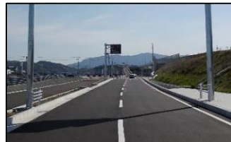
徳島小松島港 (臨港道路の整備)
