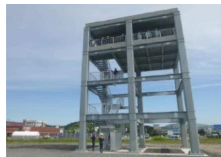
津波避難タワー(船川港)
