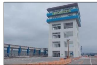
新島港 (津波避難施設の整備)
