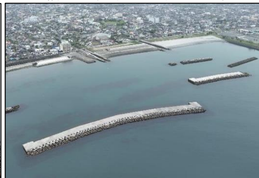
高波を減衰させる離岸堤 (指宿港海岸)
