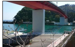
長島港 (橋梁の改良)
