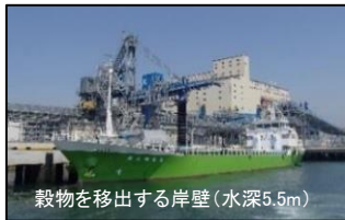
水島港 (岸壁の整備)
