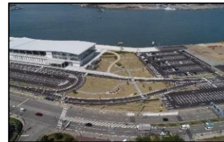
金沢港 (緑地・道路の整備)
