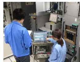
(航空保安施設点検実施状況)
