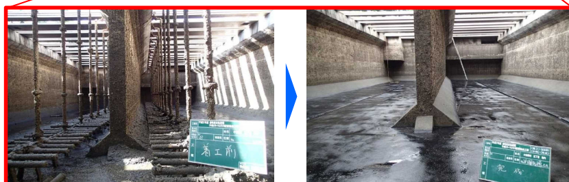
既存施設の有効活用事例（調整池へ改造）
