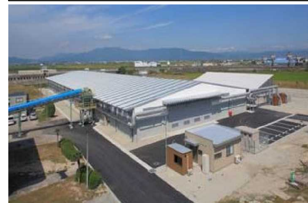
汚泥コンポスト化施設
