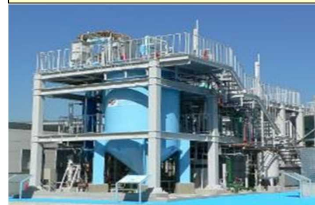
リン回収施設
