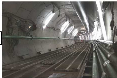
施工中の第二田柄川幹線シールド坑内
