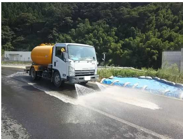
▲散水による現場の温度低下
