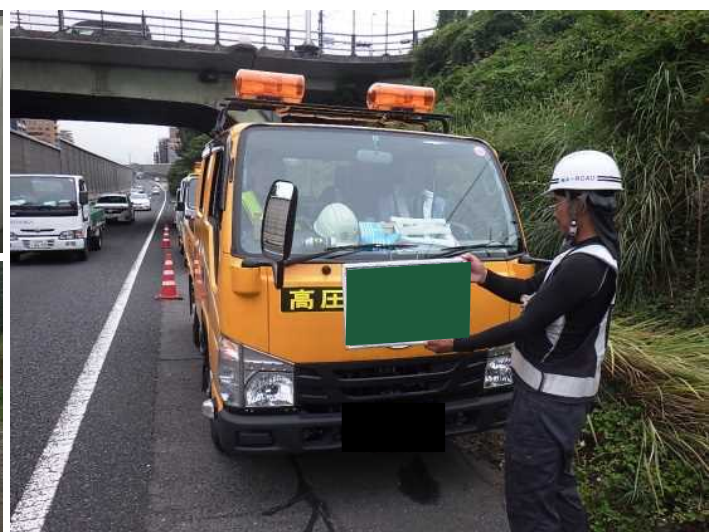
▲保守工事等、現場に休憩所が確保できない場合の工夫 (車内での休憩)
