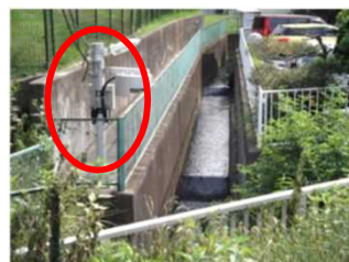
水位計の設置
