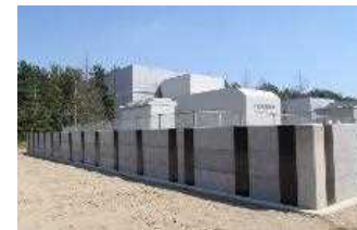
防水壁の設置
