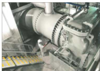
雨水ポンプの整備
