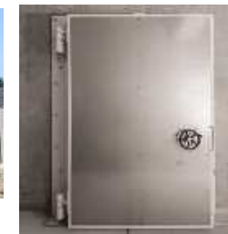
防水扉の設置
