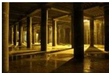
貯留施設の整備
