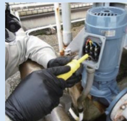
【ポンプ保全に関する技術研修】
