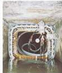
プラスチック材により既設管渠の内面を被覆
