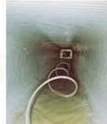
プラスチック材により既設管渠の内面を被覆
