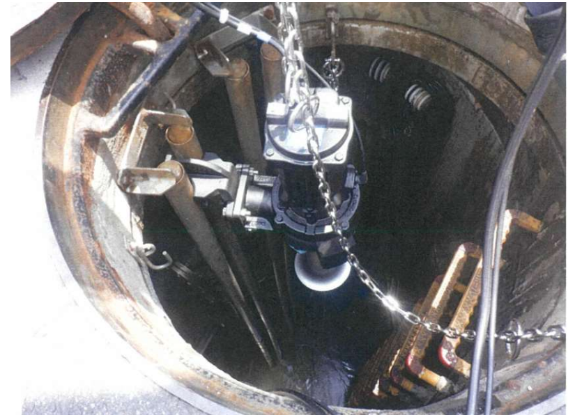
高効率型マンホールポンプの設置
