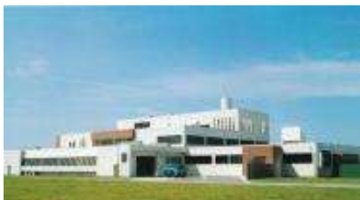
秋田市汚泥再生処理センター 電力使用量：約560MWh/年 負荷率：約50%
