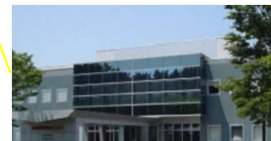
総合食品研究センター 電力使用量：約870MWh/年 負荷率：約54%
