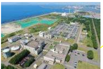
秋田臨海処理センター 電力使用量：約12,000MWh/年 負荷率：約78%
