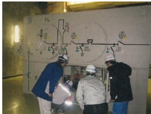
電気関係現地調査
