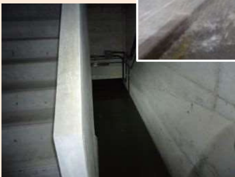
平成29年 台風21号 （左下：守山ポンプ場、右上：東近江市内）
