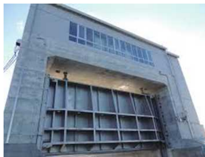
施工例：河川の防潮ゲート
